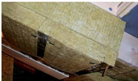
Dwuwarstwowe ocieplenie połaci poddasza użytkowego – między i pod krokiewmi.
