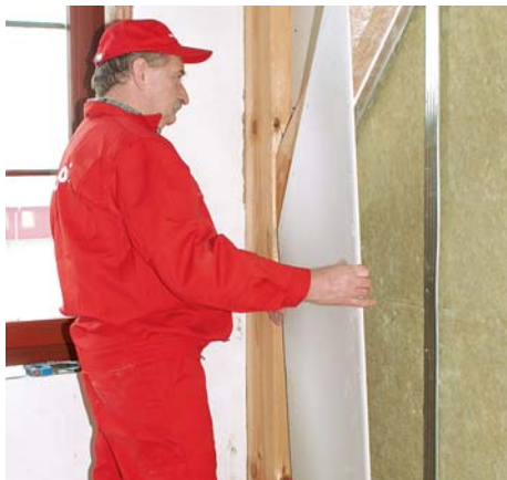
Montujemy okładziny drugiej strony ściany.
