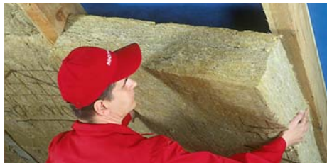
Przymierzamy przycięte płyty do rozstawu między krokwiami.
