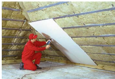
Montujemy okładziny połaci i stropu nad poddaszem.
