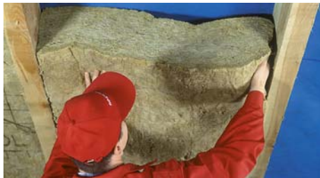
Starannie układamy pierwszą warstwę ocieplenia między krokwiami.
