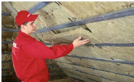
Pod krokiewmi układamy drugą warstwę ocieplenia.
