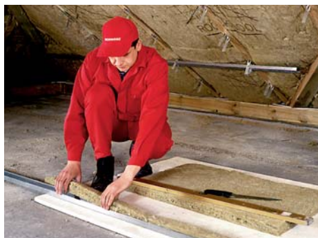
Profile nośne typu C wypełniamy paskami wełny.
