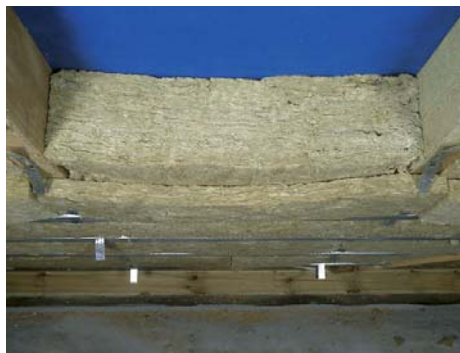
Montujemy profile typu C do wieszaków.
