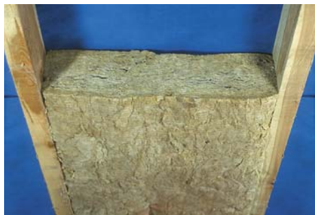
Płyty TOPROCK ułożone między krokwiami.
