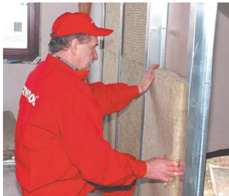
Między profilami układamy izolację akustyczną z płyt ROCKTON .
