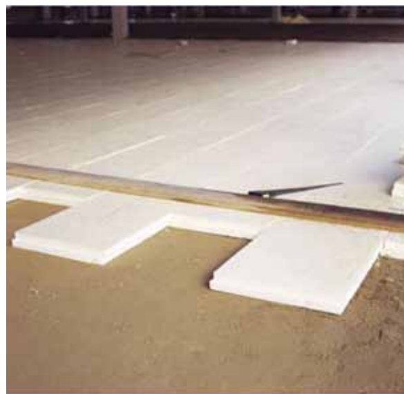
Układanie warstwy termoizolacyjnej z płyt URSA XPSA bezpośrednio na odpowiednio przygotowanym gruncie
