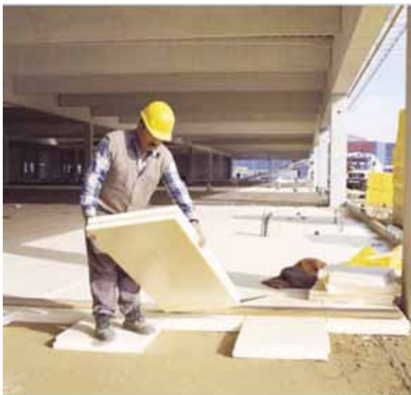
Układanie warstwy termoizolacyjnej z płyt URSA XPSA bezpośrednio na odpowiednio przygotowanym gruncie
