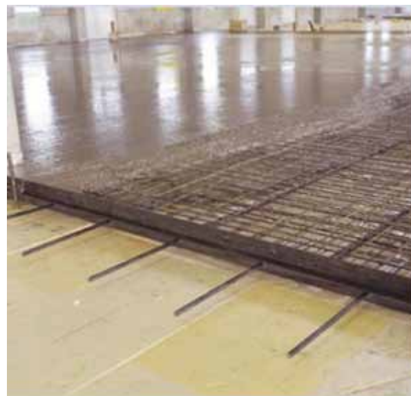
Wykonanie płyty żelbetowej
