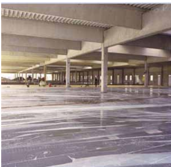
Układanie warstwy poślizgowej
